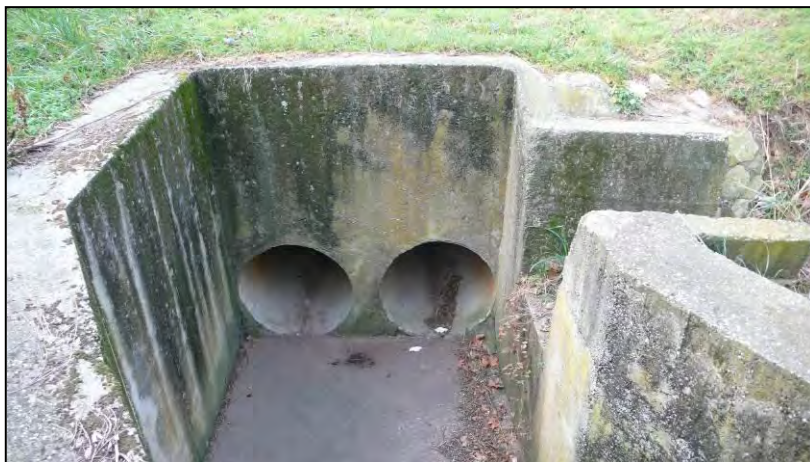
Photo 4 : Buses en diamètre 1000 mm sous la RD6113
