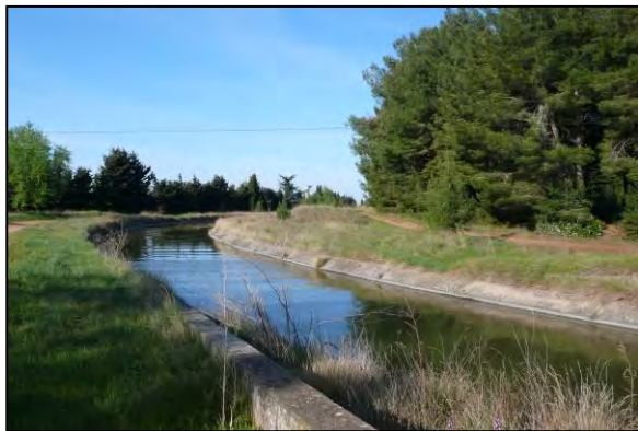
Photo 2 : Canal des Costières au Nord-Ouest de la zone d'étude
